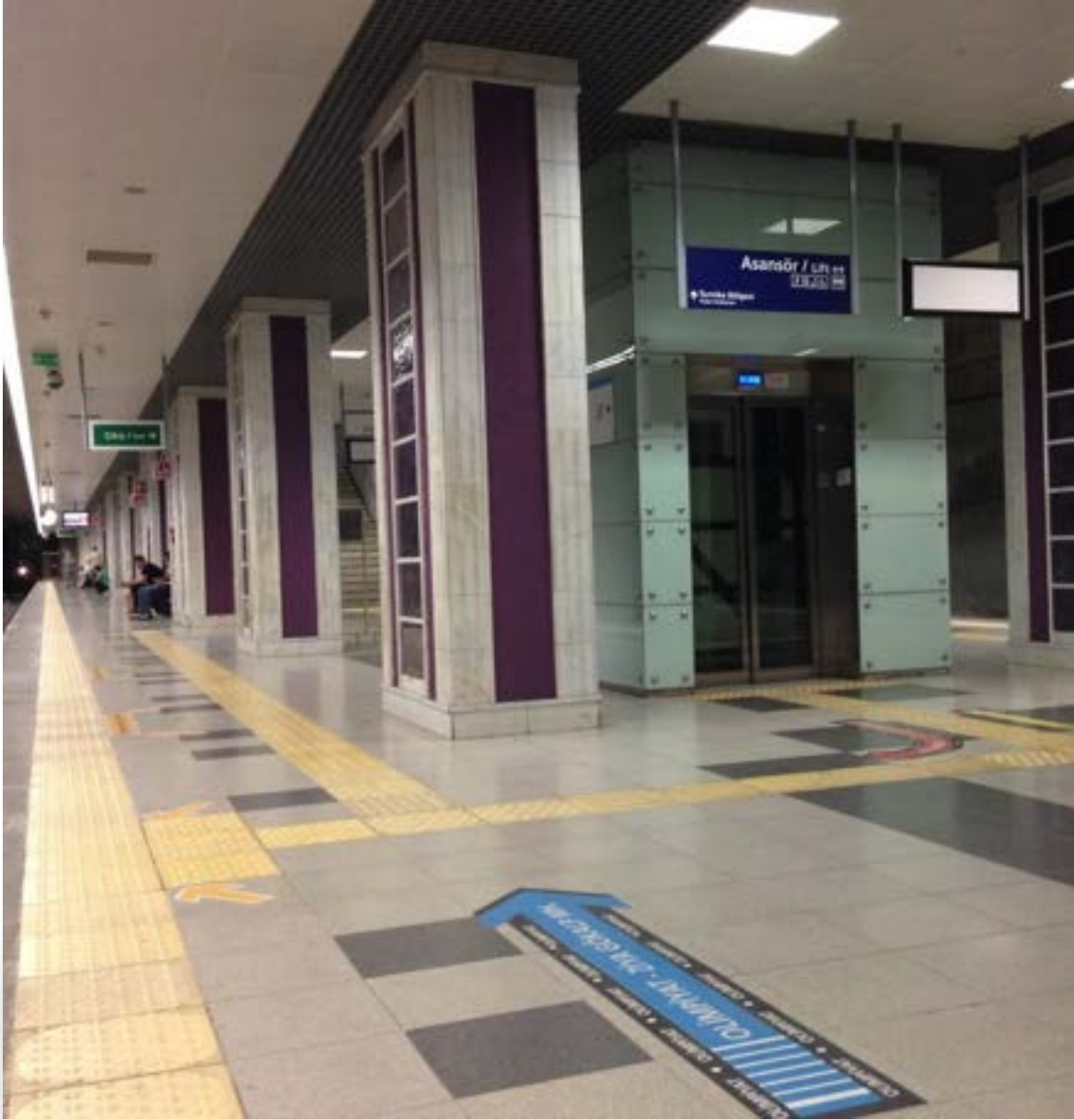
Fotoğraf 9. İstanbul Metrosu binış peronuna asansör ile erişim, yönlendirme ve bilgilendirme işaretleri, hissedilebilir yürüme yüzeyi işaretleri.
