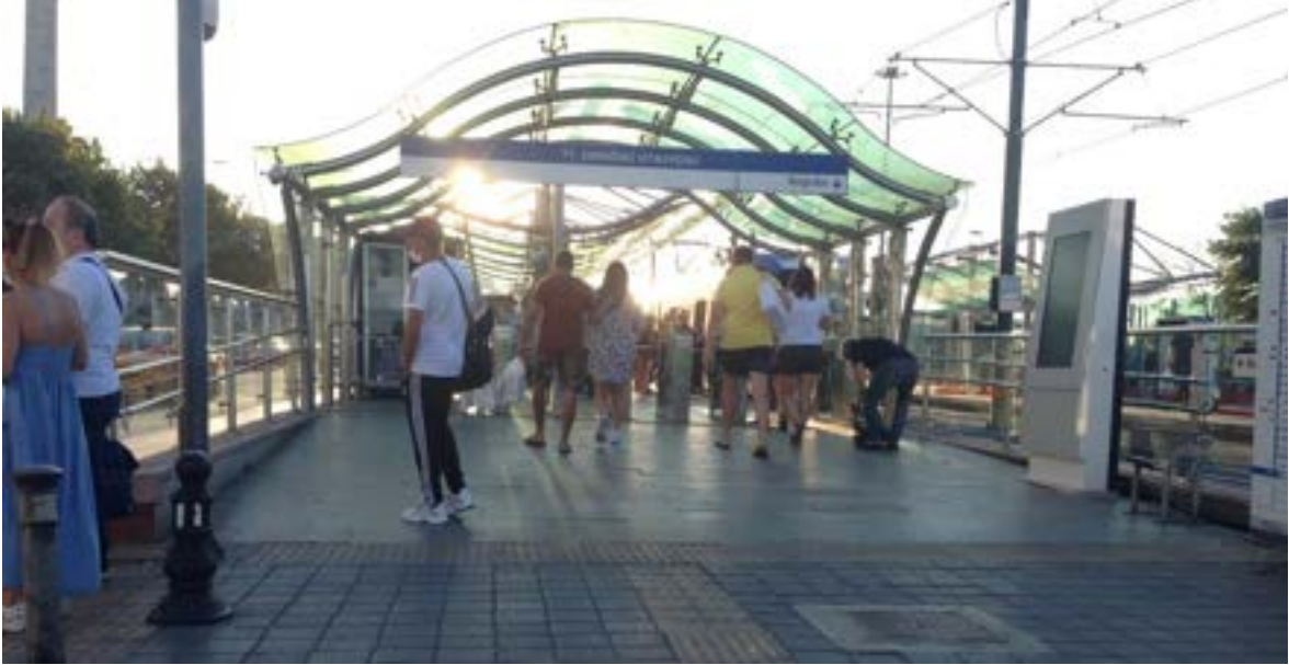
Fotoğraf 4. İstanbul Eminönü hafif raylı sistem peronu. Rampa eğimi ve genişliği, zemin kaplaması uygun, hissedilebilir yürüme yüzeyi işareti uygulanmış, yönlendirme bilgilendirme işaretleri yeterli ve doğru konumlandırılmış.
